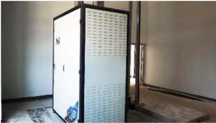
项目名称: 西安航天新城公交停车场 项目性质: 单供暖5000平方米 设备选型: 低氮冷凝式模块炉500KW 1台
